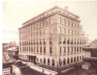
建築当時の綿業会館
