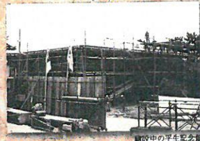
建設中の平生記念館
